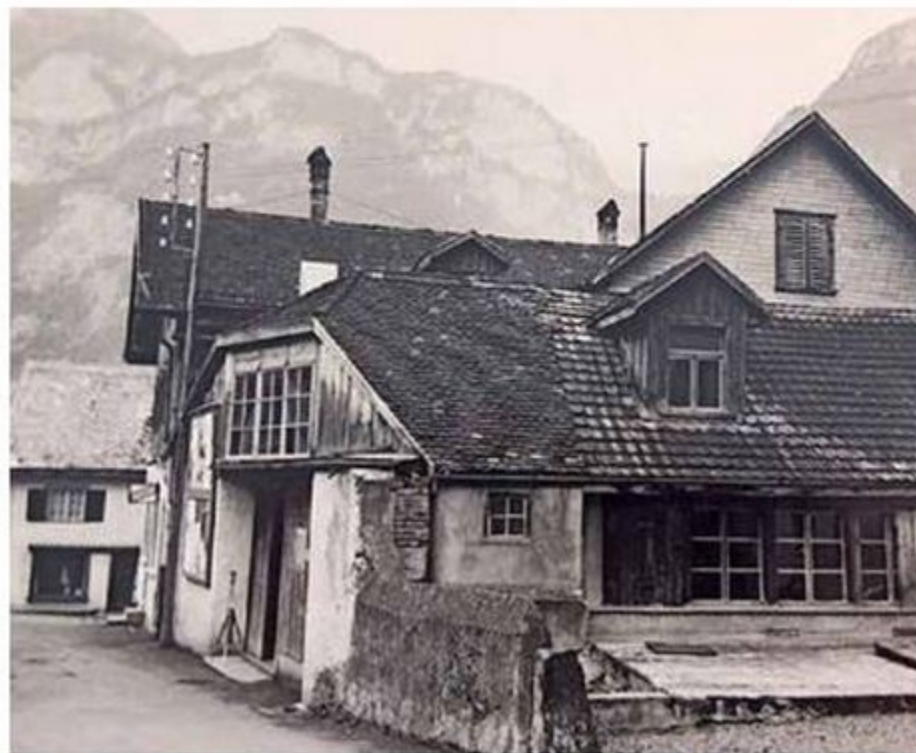
Zeitzeuge: Das Gebäude der Wagneri Wildhaber, Johann Schlegels Arbeitsplatz in Flums, wurde im Jahre 1952 der Migros verkauft, welche an dieser Stelle den ersten Laden in Flums baute.
